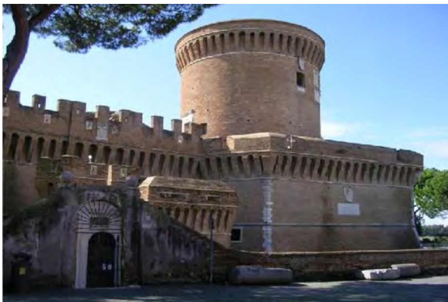
Fig. 4 – Castello di Giulio II (sede del Laboratorio).
